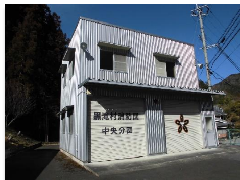
消防施設屯所(中央)
